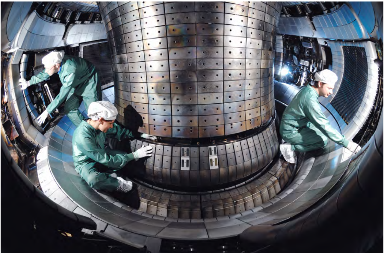
Einbau von Regelpulen in das Plasmagefäß der Fusionsanlage ASDEX Upgrade (Foto: IPP, Volker Rohde)
